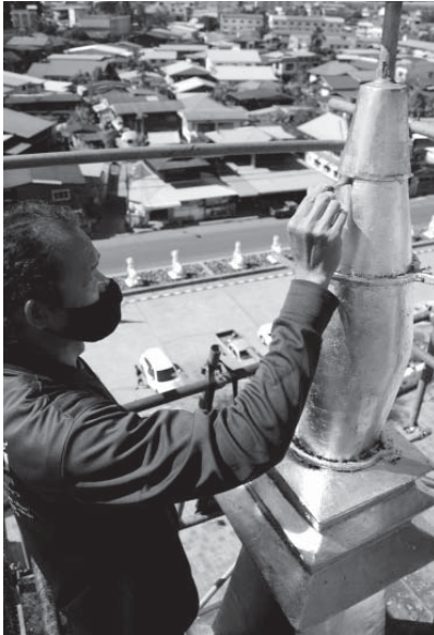
ภาพที่ ๔๒-๔๓ ช่างผู้รับเหมาดำเนินการปิดทอง พื้นที่ส่วนปลายปลียอดองค์พระธาตุเชิงชุม และการรื้อนั่งร้านภายหลังดำเนินการลงรักปิดทองสำเร็จแล้ว ถ่ายเมื่อปีพุทธศักราช ๒๕๖๔
