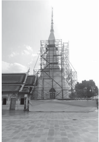
ภาพที่ ๔๒-๔๓ ช่างผู้รับเหมาดำเนินการปิดทอง พื้นที่ส่วนปลายปลียอดองค์พระธาตุเชิงชุม และการรื้อนั่งร้านภายหลังดำเนินการลงรักปิดทองสำเร็จแล้ว ถ่ายเมื่อปีพุทธศักราช ๒๕๖๔
