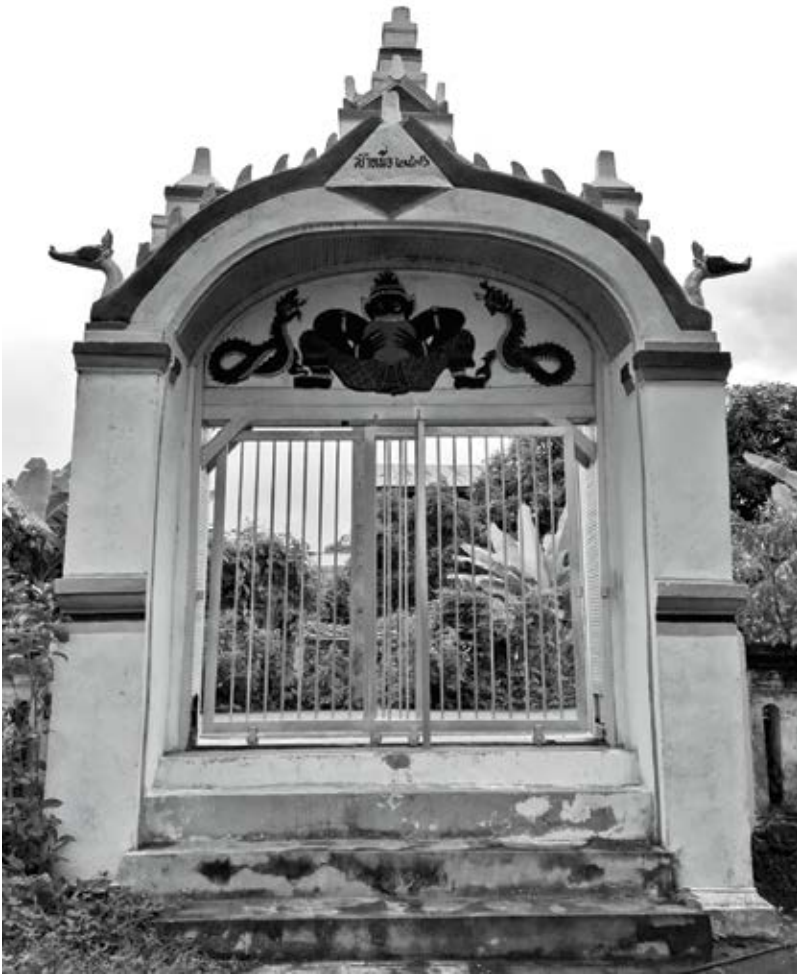
ซุ้มประตูด้านทิศตะวันตก
